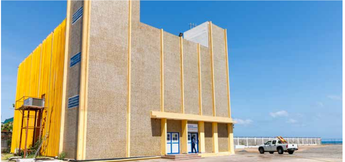
Landungsstation für Seekabel von Djibouti Telecom in Haramous, Dschibuti
